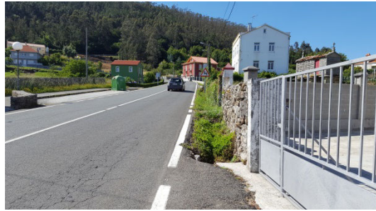
P.K. 1+290 SENTIDO AVANCE P.K. 'S
