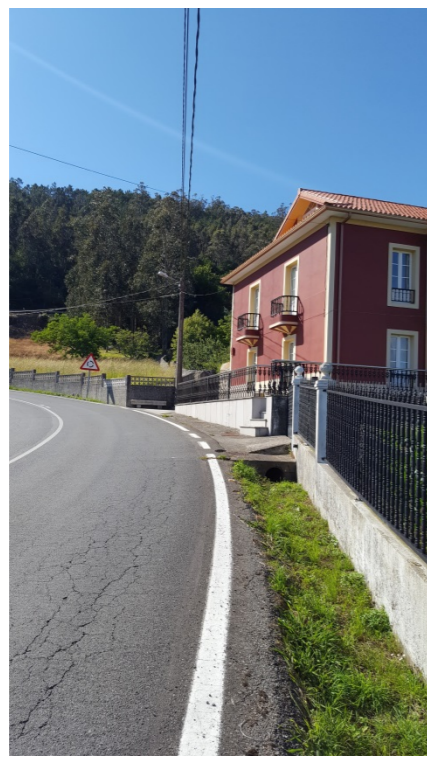
ZONA MURO PERPIAÑO
