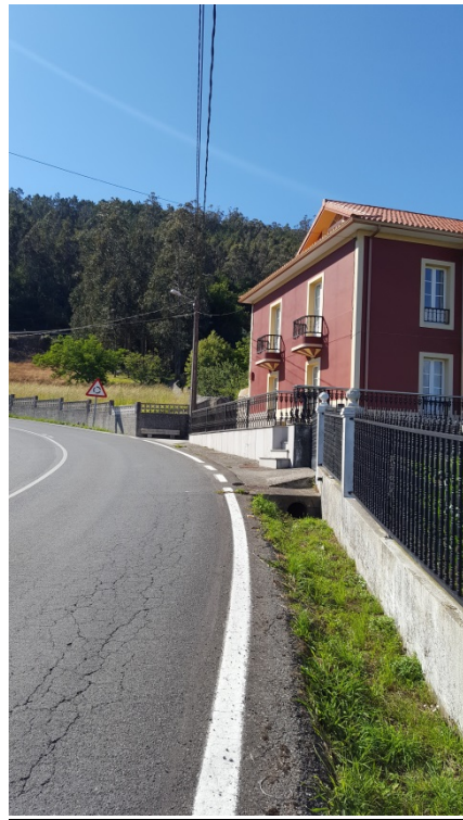
ZONA MURO PERPIAÑO
