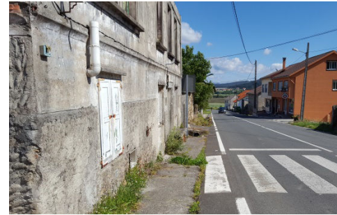
P.K. 1+275 SENTIDO INVERSO
