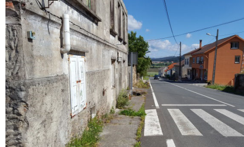
P.K. 1+275 SENTIDO INVERSO
