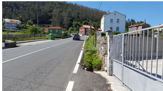
P.K. 1+290 SENTIDO AVANCE P.K.'S
