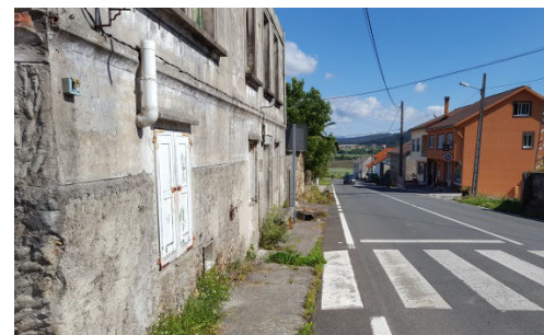
P.K. 1+275 SENTIDO INVERSO
