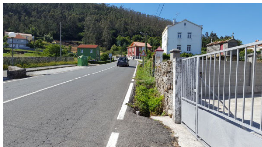
P.K. 1+290 SENTIDO AVANCE P.K. 'S
